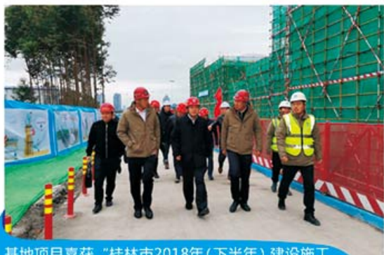
基地项目喜获“桂林市2018年(下半年)建设施工安全文明标准化工地”称号
